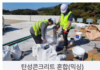
탄성콘크리트 타설 및 봉합재 설치
